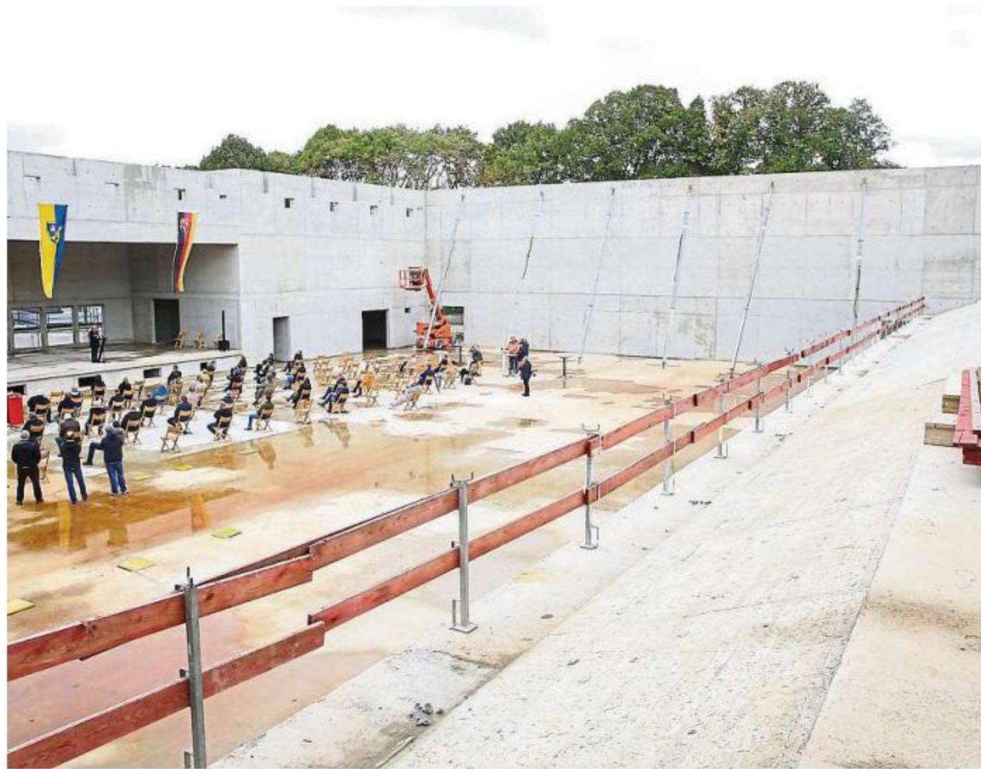
Sichtlich beeindruckt waren die Gäste des Richtfestes von der Rheinhessenhalle.
