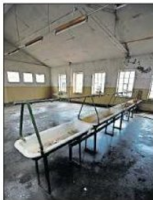
Dieser Raum im Obergeschoss diente einst als Umkleidekabine. FOTO: VIEW
